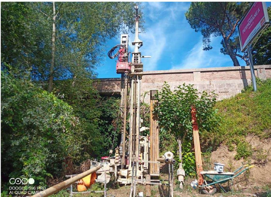
**Figura 20: Postazione del sondaggio geognostico S2.**
